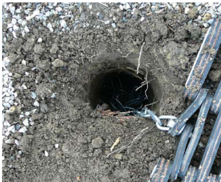
Pequeño orificio en el suelo para cadenas de anclaje + base de punto (ca. Ø 5.00 cm)
