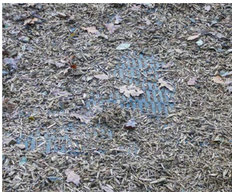
Alfombras protectoras de césped después de la instalación (abierto para la foto)
